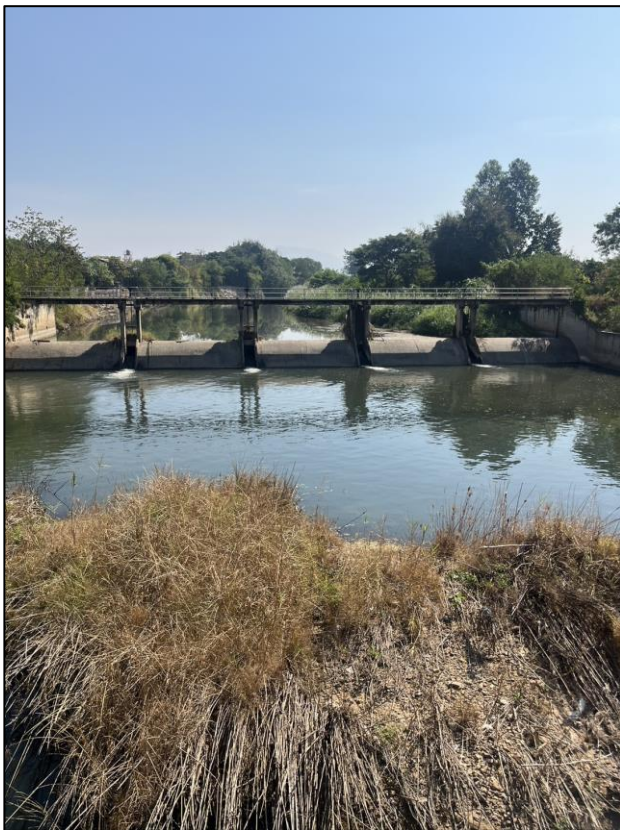
เหนือแนวสำรวจ
